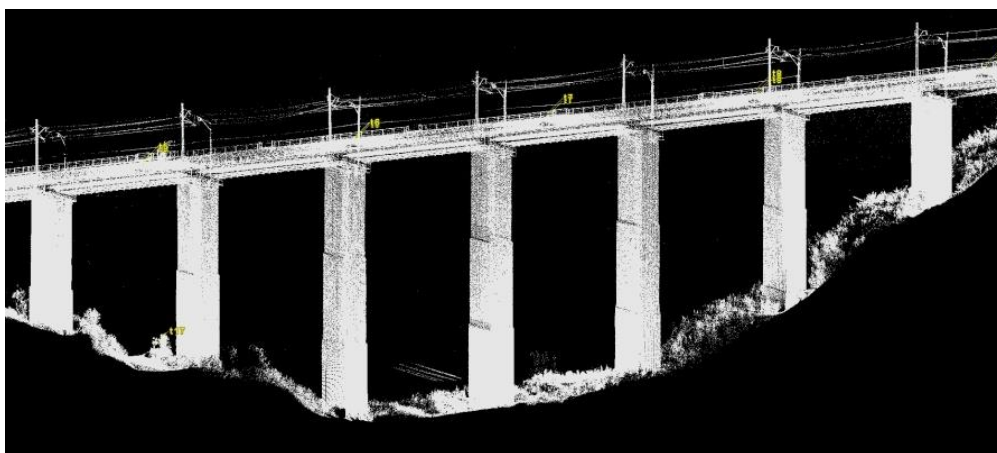
Рис. 1. Сканирование железнодорожного моста
