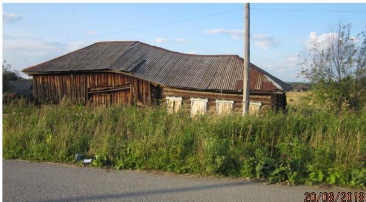
Рис. 4. Осадка части дома № 10 по ул. Дарьинская (на геоморфологической схеме – область фото № 3), расположенного на контакте аллювиальных суглинков р. Чусовая (верх, север) и песчано-галечниковых отложений р. Дарья
