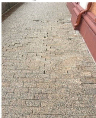
Рис. 1. Суффозионные процессы на ул. Петропавловской, 57 (фото автора)
