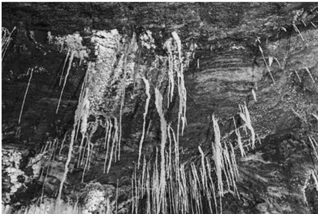
Рис. Тонкие соляные сталактиты-бочки на арматуре шахты
