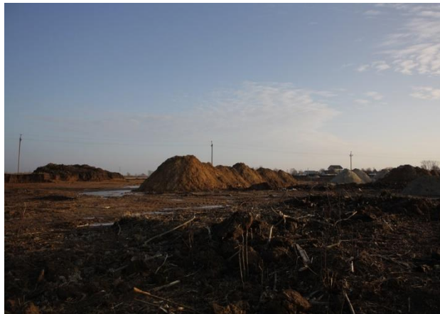
Рис. 2. Внешний вид участка в процессе технической рекультивации
