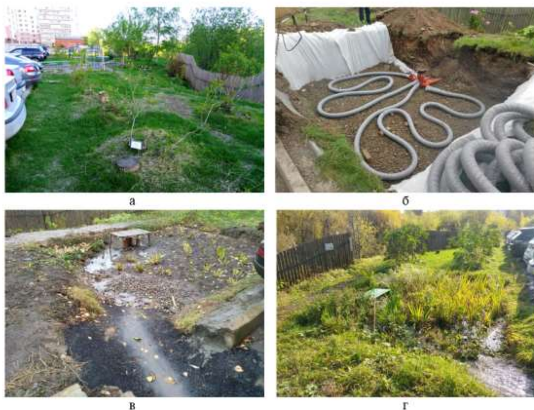
Рис. 2. Этапы строительства и формирования дождевого сада
