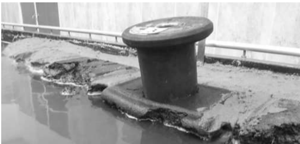
Рис. 2. Постепенное обрушение нагрузки в процессе оттаивания основы
