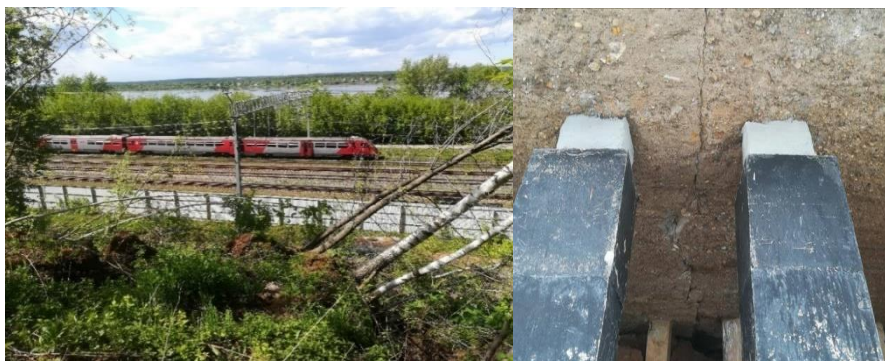
Рис. 3. Слева – подошва оползня, справа – трещина дороги (фото автора)
