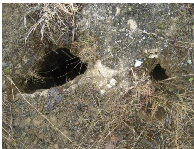
Рис. 3. Карстовый провал в кювете автодороги Орда-Ашап Ординского района
