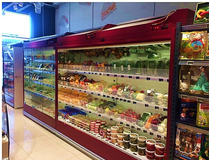
Рис. 3.3.5. Холодильное оборудование нового формата магазинов «Семья»
