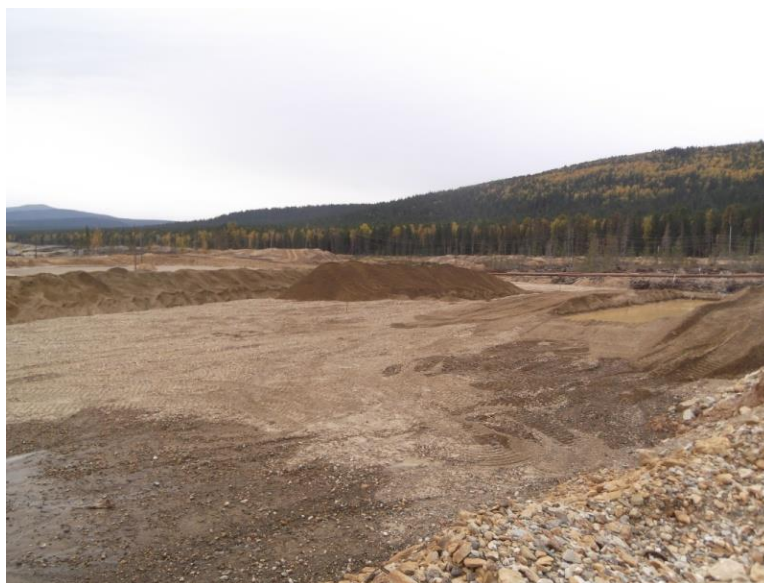
Рисунок 2.10 – Фильтрационное поле системы очистки оборотной воды (справа – напорная траншея; на заднем плане – отводящая траншея)
