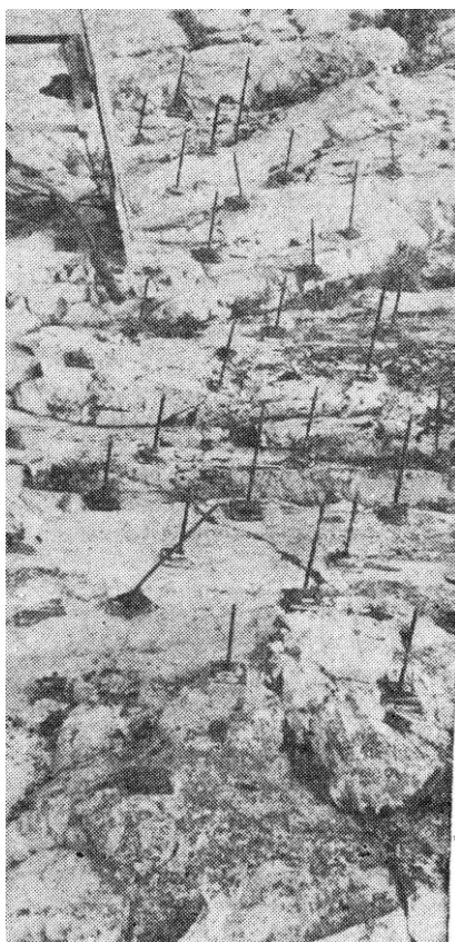
Один из способов крепления неустойчивых обвальных накоплений на склонах к коренному грунту
