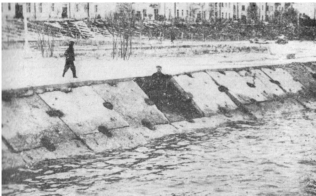
Бетонные «одежды» берегов часто не выдерживают ударов волн. Разрушенное крепление из сборного железобетона на берегу Камы в районе поселка Уральский
