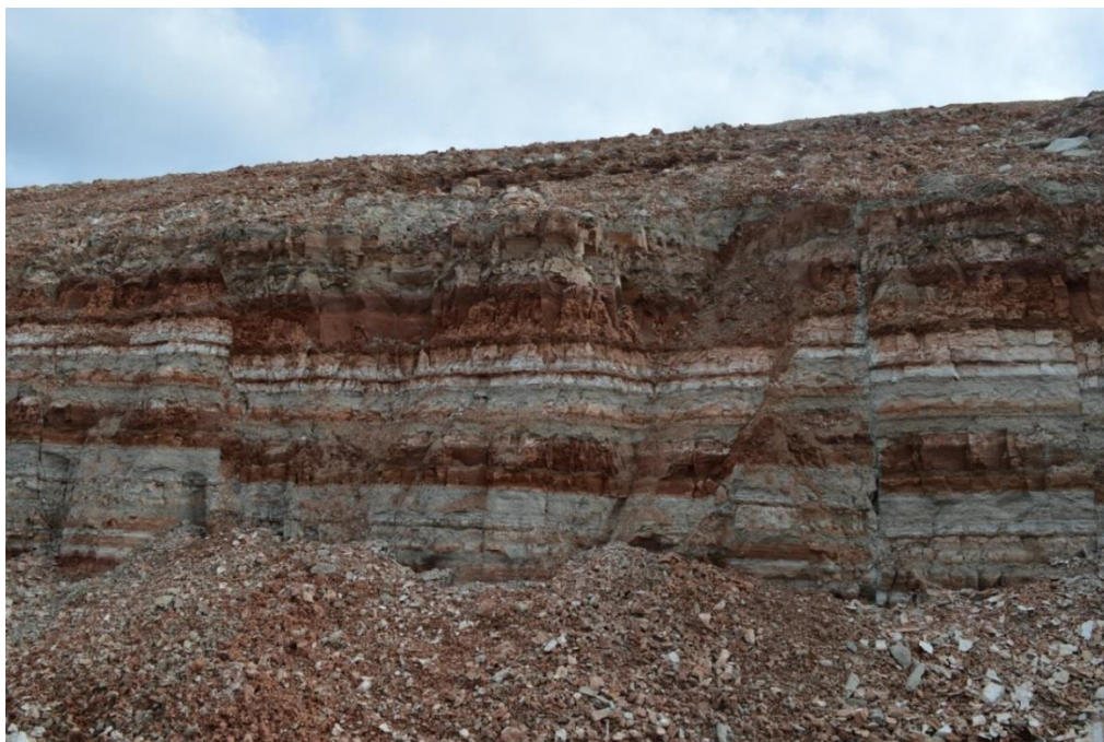
Рис. 1. Фото правого склона дорожной выемки у села Гребени с тектоническими нарушениями залегания осадочных пород.
